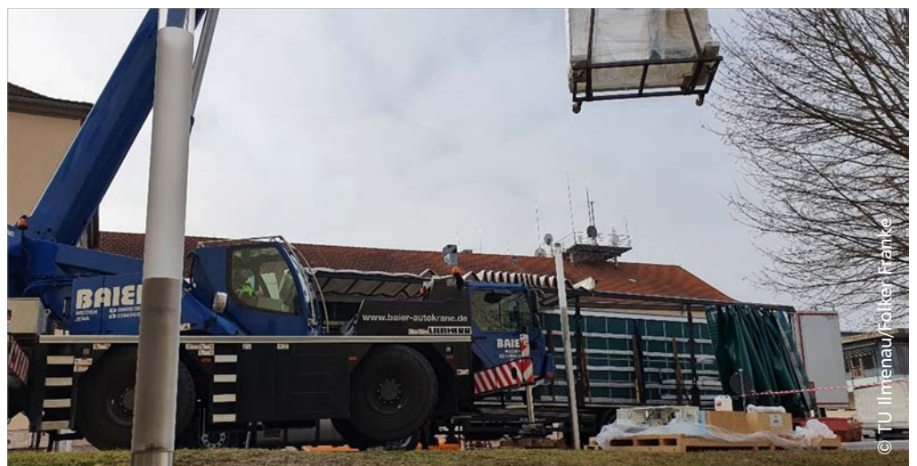
Anlieferung CNC-Maschine „CLX 350“ des Herstellers DMG MORI am 03. März 2021
