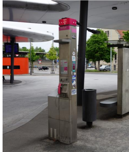
Kleinzelle outdoor (Mikrozelle) Bis einige 100 m Abdeckung Rundstrahlend oder gerichtet Antennendiagramm statisch
