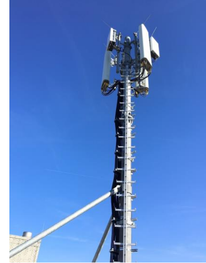
Makrozelle Bis einige km Abdeckung Primär gerichtet Diagramm statisch oder dynamisch
