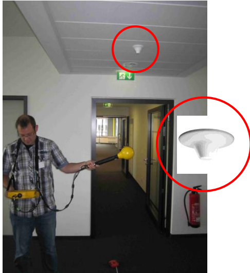
Kleinzelle indoor (Picozelle) Einige 10 m Abdeckung Rundstrahlend oder gerichtet Antennendiagramm statisch
