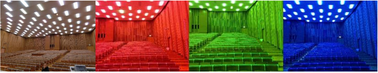
Abbildung 5: Hörsaal an der TU Berlin mit steuerbarer RGB-W-Leuchtstofflampenbeleuchtung
