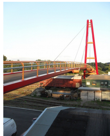
Die neue Fußgängerbrücke
