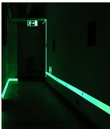
Abbildung 9: Situation 1 nach DIN 67510-3 12 (Lichtspeicherndes Sicherheitsleitsystem).
