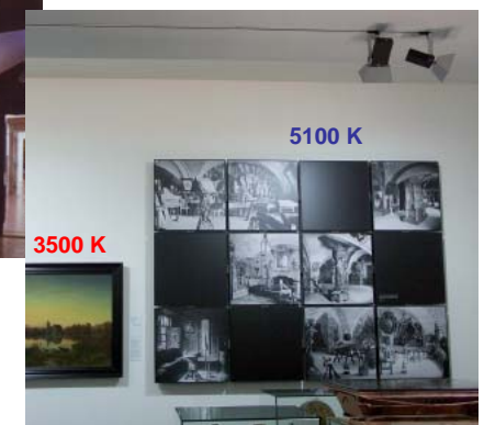
Exponatbeleuchtung mit zwei Lichtfarben
